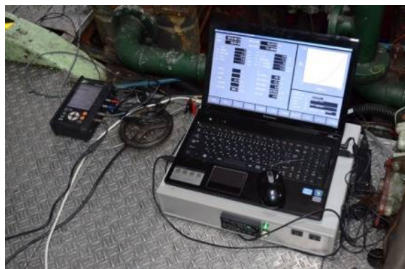
図 10 機関室に設置した乗船調査中の計測用パソコン
