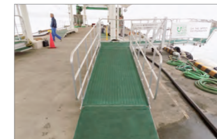
浮棧橋設置のタラップ 先端のスロープ部分が上下する
