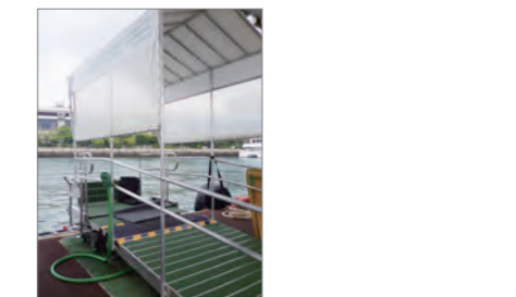
浮棧橋設置のタラップ 潮位に合わせリフターを動かすことで微調整する
