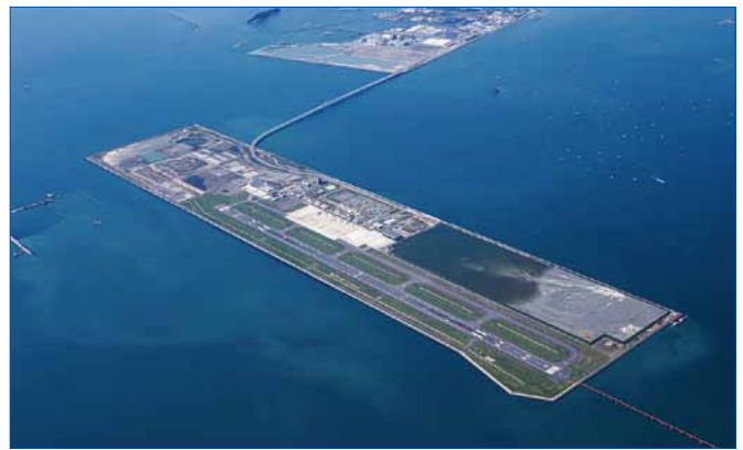
北九州空港の全景
